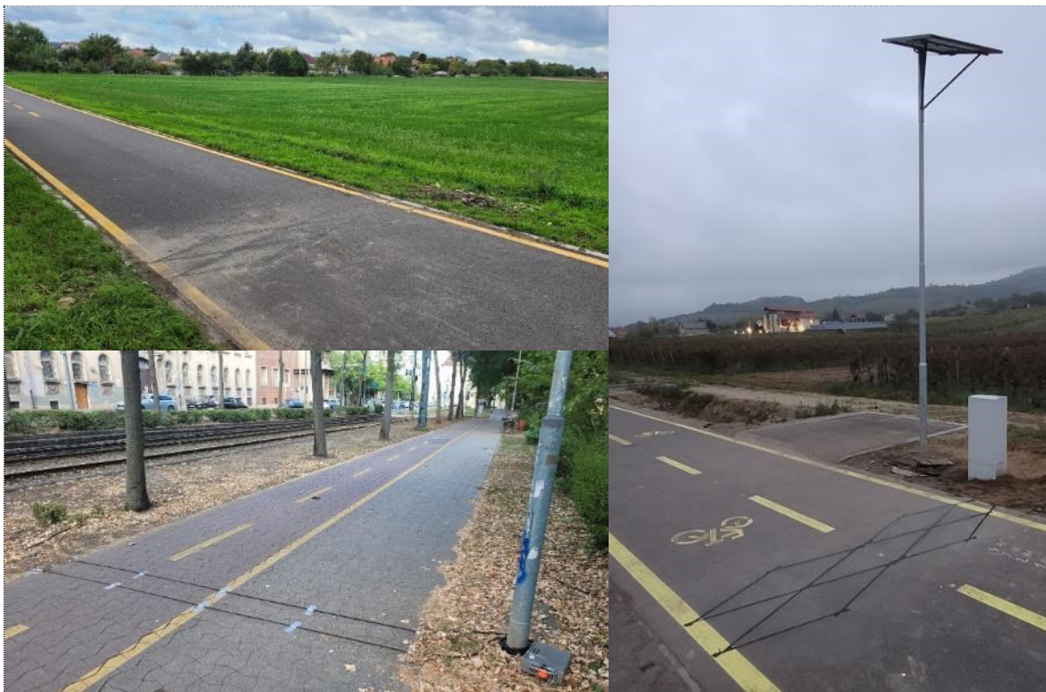
34. ábra Eco-Counter típusú telepített forgalomszámláló berendezések, bal felül: akkumulátoros tápellátás, a berendezés a föld alatt van elhelyezve; jobb oldalon: napelemes tápellátás, a berendezés szekrényben található; bal alul: gumicsöves mobil mérőeszköz (Fotók: Értékterv Kft.)
